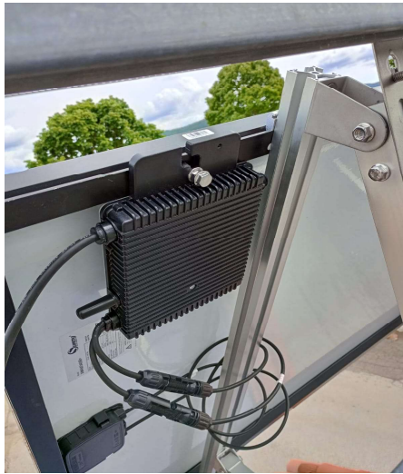
Sesto passaggio Piazzare il Micro Inverter sul modulo fotovoltaico
