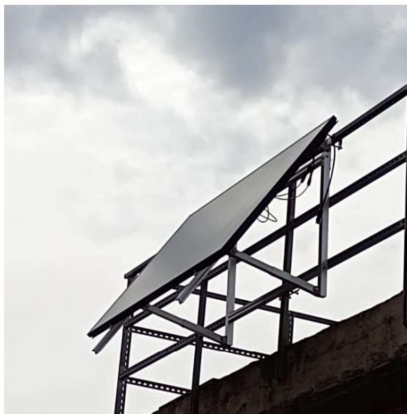
Immagine di installazione tipo su ringhiera
