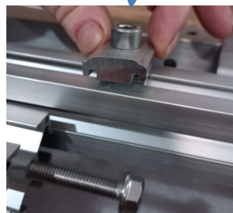
Sostituire gli attacchi ad L con i martelletti per fissaggio Pannello a struttura
